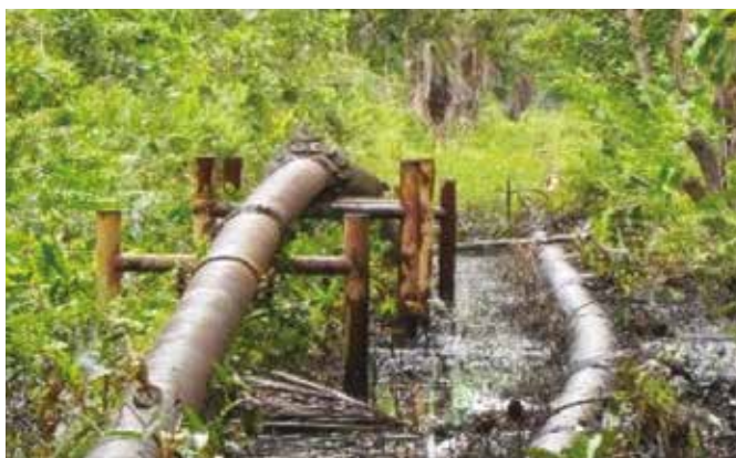
Imagen 65: Ductos en pésimas condiciones, que demuestran como ejercen la actividad petrolera.
